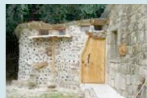
Les toilettes sèches
