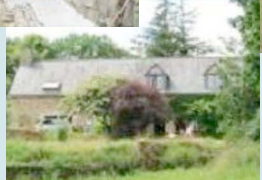
Le bâtiment principal
